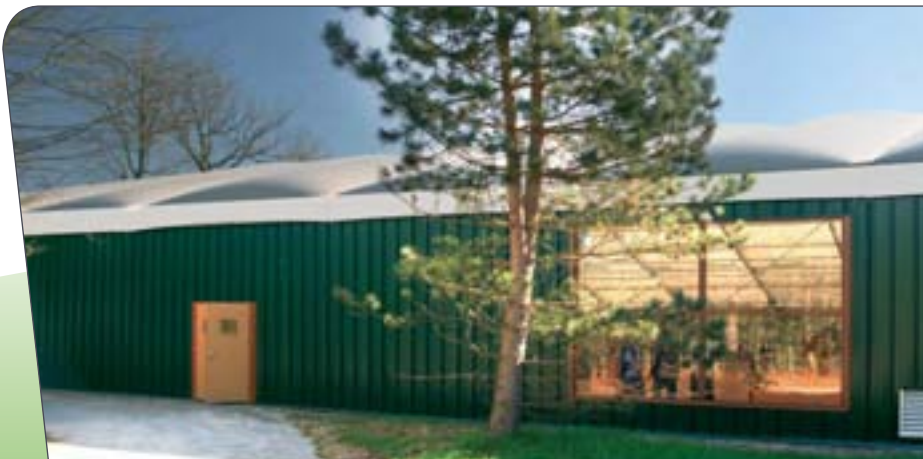
Era necesario un color específico para permitir que la estructura se integrase de manera natural con el paisaje
