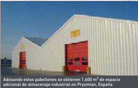
Estructura básica de almacenaje con cubierta térmica y revestimiento exterior en panel sándwich para un mejor aislamiento
